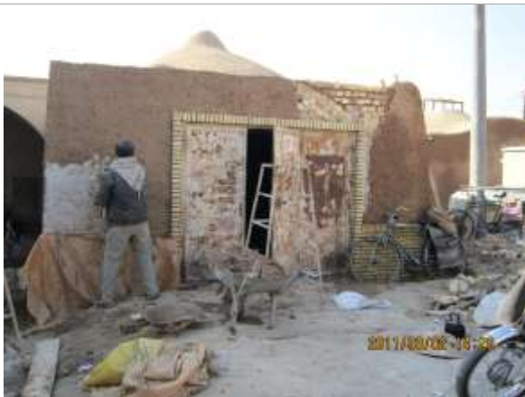
مرمت دیوار های کارگاه رنگرزی
