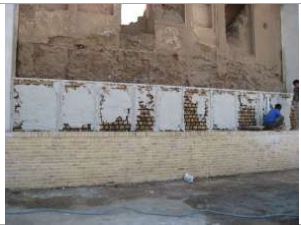
قاف بندی دیوار جنب پارکینگ
