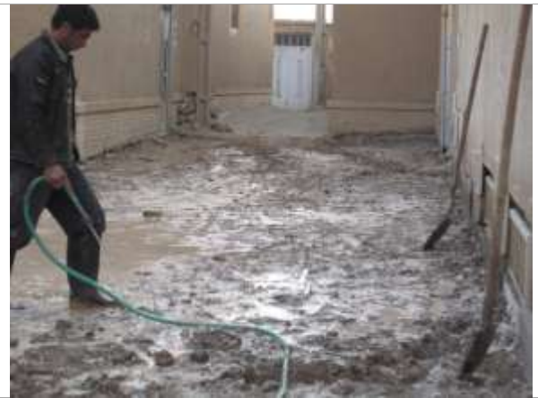
زیرسازی محور گریچه جهت کف سازی
