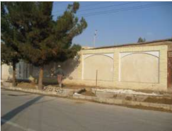
بهسازی وبدنه سازی دیوار های محور علوی
